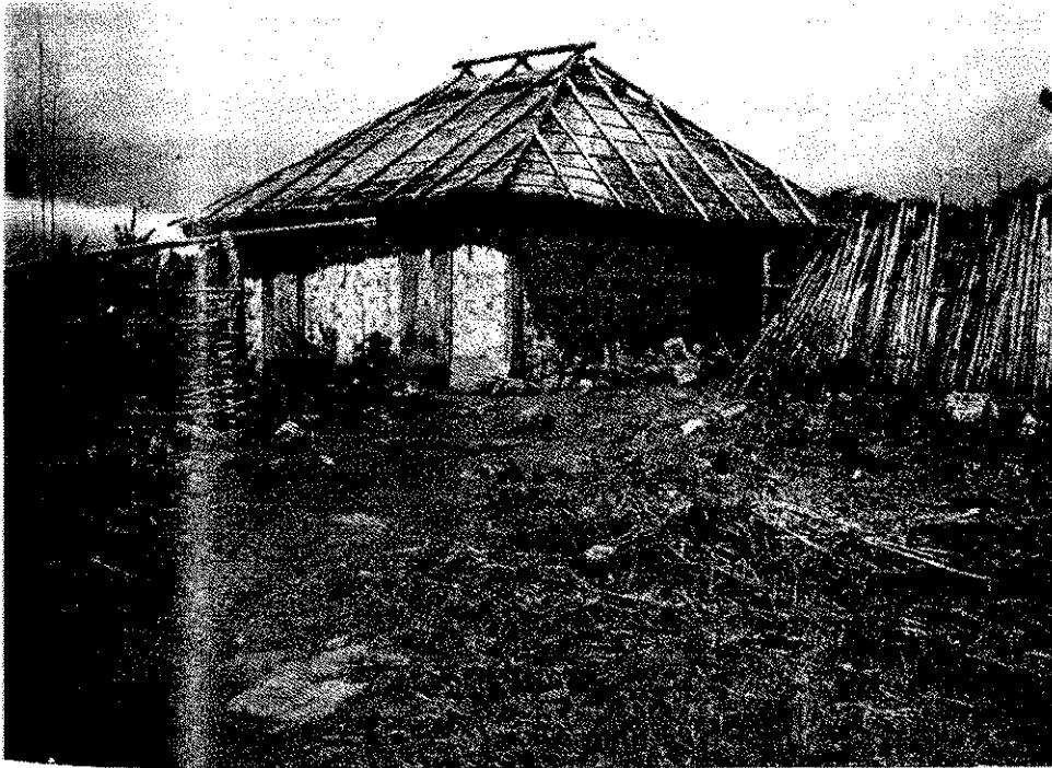
LES CASES Case à murs de calumet (L'Eperon)
