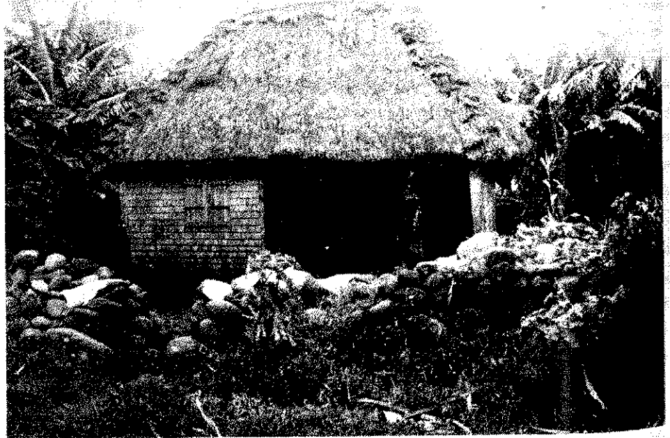
LES CASES DE LA REGION DU CHAMP-BORNE Case de bardeaux, toit de paille de cannes. Varangue en coin.
